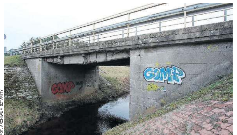
Stara przeprawa na Jodłówce zostanie rozebrana, w jej miejsce pojawi się nowy most
