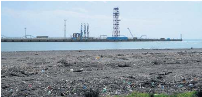
Nowa gruzińska rafineria Kulevi przyjmuje ropę z Rosji. Zakład nad Morzem Czarnym rozpoczął działalność w październiku
