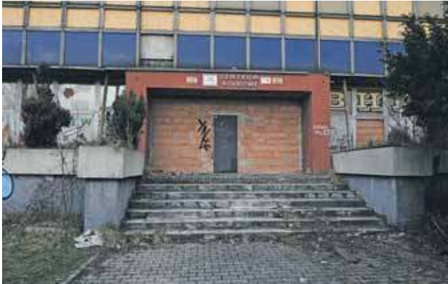
Tarnogórski PINB, na koszt Skarbu Państwa, zabezpieczył budynek
