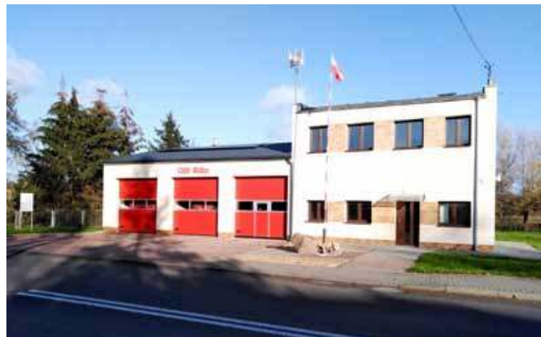
Tak prezentuje się remiza Ochotniczej Straży Pożarnej po przebudowie
