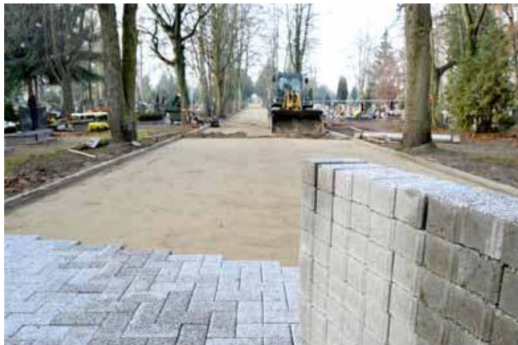
Trwa remont alejek na cmentarzu przy ul. T. Kościuszki
