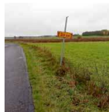
Drogowcy uzupełnili ubytki w znakach drogowych na odcinku drogi z Ognicy do Szadzka
