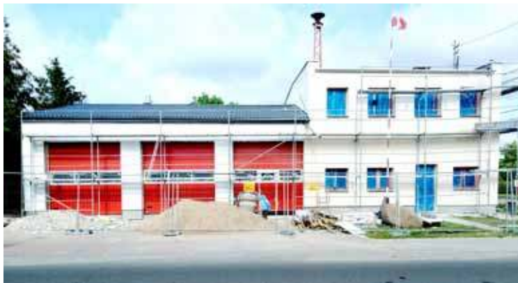
W ramach prac ocieplono budynek i wykonano elewację budynku
