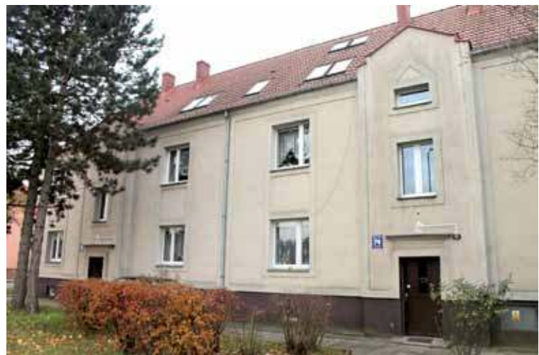
W kamienicy na Kościuszki 74-76 w piątek, sobotę i niedzielę rano, do momentu naprawy instalacji gazowej, mieszkańcy marzli i nie mieli ciepłej wody
