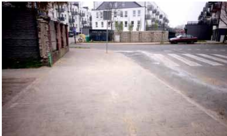
Zakończył się remont chodnika na ulicy Zwycięzców. Nowy chodnik wykonano z kostki betonowej
