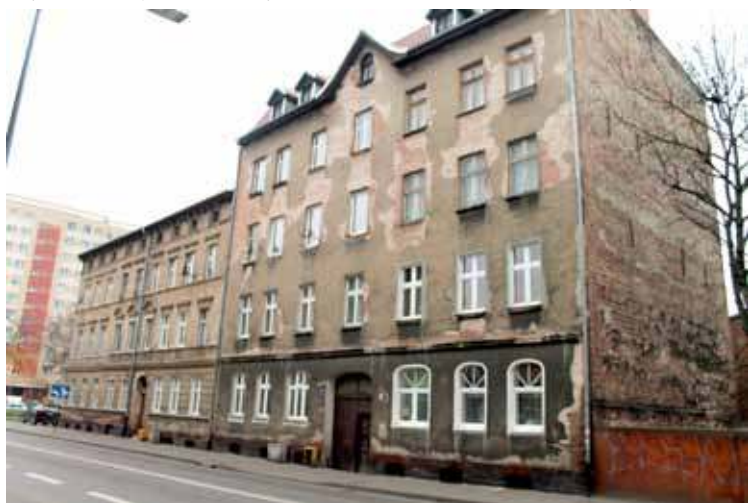
Przy ul. Konopnickiej 2, 3 i 10 w 2021 r. zaplanowano wykonanie łazienek równocześnie z modernizacją całego budynku
