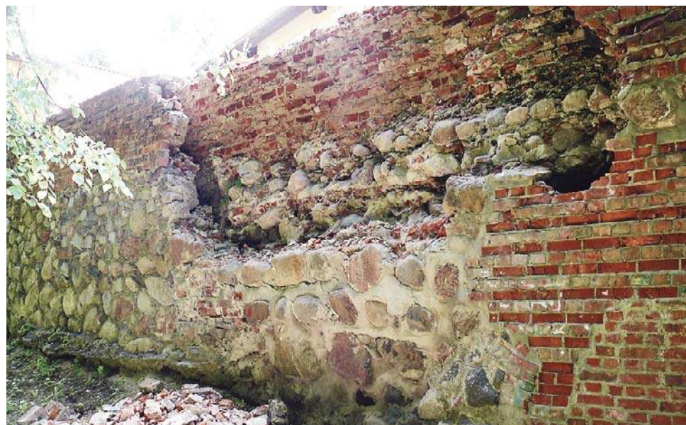
Remont murów obronnych w Pasłęku wymaga ogromnych funduszy i nakładu pracy
