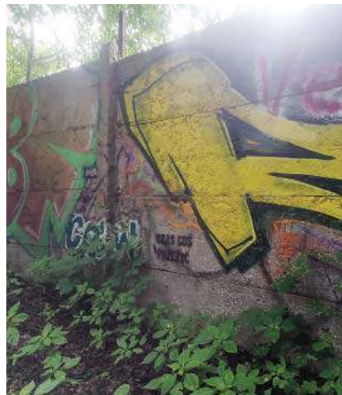
Betonowy płot przy „Łynostradzie”. Las Miejski
