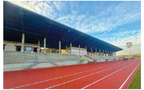
Ratusz chce zorganizować miejsce ukrycia w powstającym budynku socjalnym na miejskim stadionie
