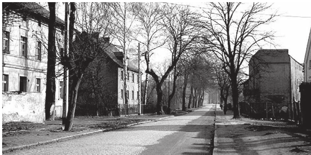
Ulica Strzelna - to zdjęcie zrobiłem w 1972 od strony skrzyżowania. Widać pas asfaltu - o tyle poszerzono ulicę. Widać też sporo drzew po jednej i drugiej stronie, do dziś przetrwało niewiele. Po prawej kawałek budynku, w nim przez lata była piekarnia ze sklepem. Następny budynek dziś nie istnieje, został wyburzony, a w jego miejscu w 2000 roku Bogusia i Henryk Wosiowie wybudowali piętrowy budynek z lokalami handlowymi na parterze
