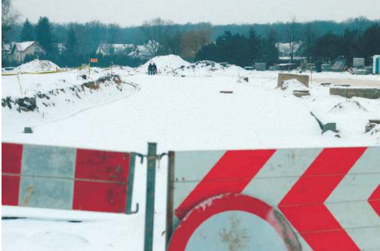
Budowa ulicy Kusocińskiego potrwa do 2020 roku
