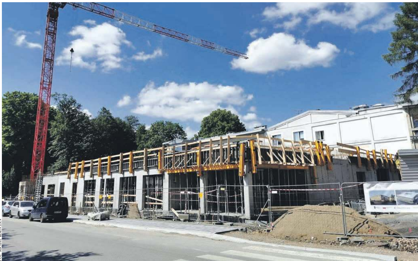
Trwa budowa nowego budynku balneologii w Krzeszowicach
