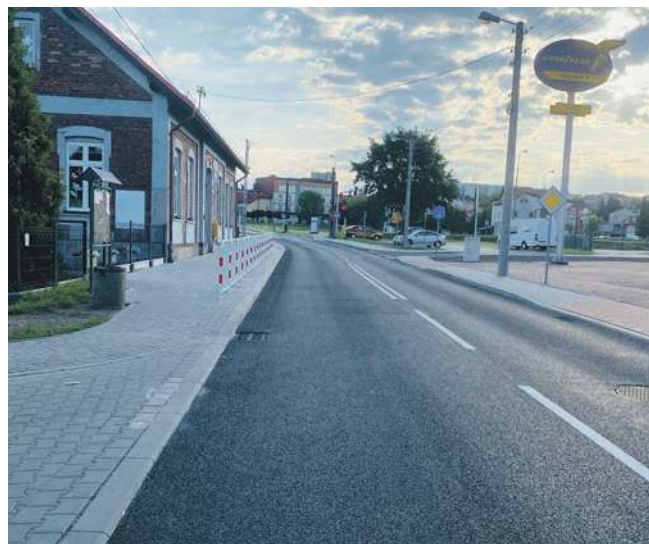
Ulica Ochronkowa po remoncie
