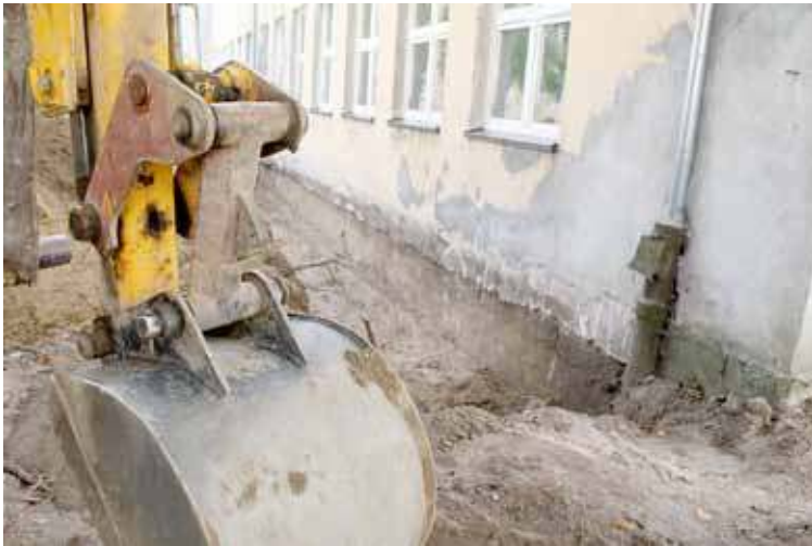
Fundamenty szkoły mają zostać zaizolowane, co ma zapobiec przedostawaniu się wilgoci na wyższe kondygnacje ścian
