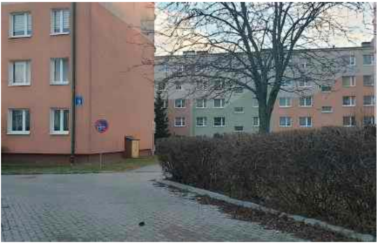
Dodatkowe latarnie przydałyby się m.in. na osiedlu przy ul. Witosa, gdzie alejki między blokami toną w ciemnościach
