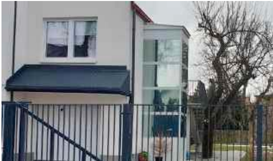
Prowadzona przez radnego, z naruszeniem przepisów, przebudowa garażu na windę została zalegalizowana
