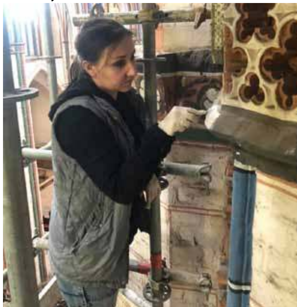
Pobrane zostały próbki farb, które poddane zostaną ekspertyzie. Na jej podstawie będzie wiadomo w jakiej kolejności były nakładane
