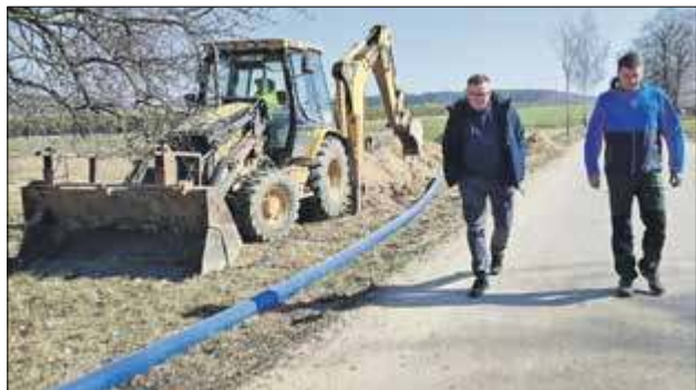
Trwają prace w zakresie przebudowy odcinka sieci wodociągowej w Łuniewie
