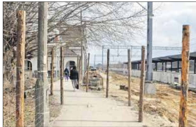
Stan tymczasowego przejścia na peron na dworcu PKP w Białej Podlaskiej woła o pomstę do nieba
