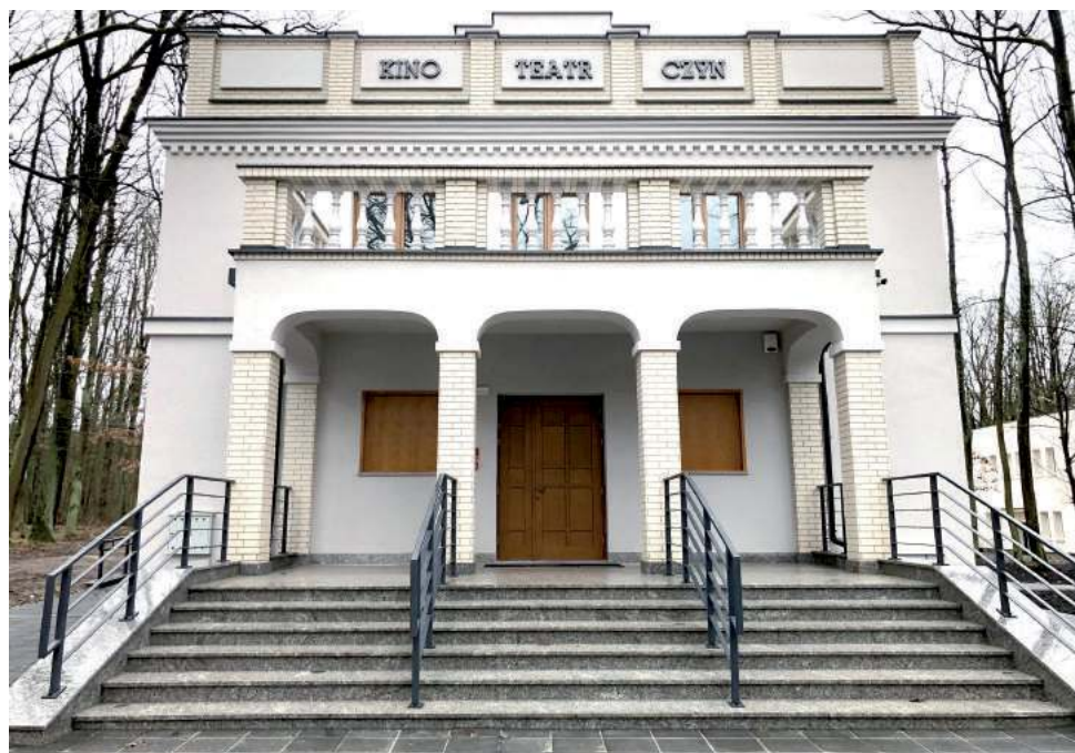
Ściana frontowa kina z odnowioną attyką i wszelkimi detalami. Wymieniona została nawierzchnia placu przed wejściem głównym, wykonane chodniki i parking
