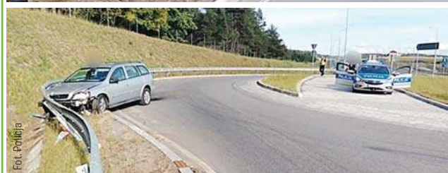
Na zdjęciach dwa zdarzenia na rondzie z 2025 roku i ostatnie, gdy samochód przejechał przez środek ronda
