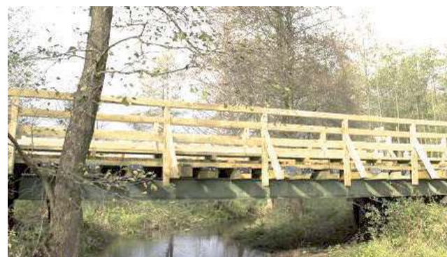
Z daleka widać, że przeprawa nad Bystrą przeszła remont. Gminę kosztowało to ok. 30 tys. zł
