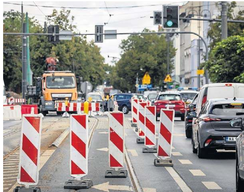
Skrzyżowanie Gdańskiej i Kamiennej ma tymczasową nową organizację ruchu. Potrwa to przez pierwszy tydzień września
