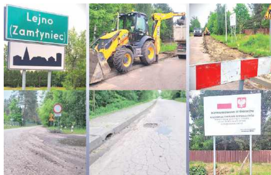
Zmodernizowanych zostanie prawie 1000 metrów nawierzchni asfaltowej
