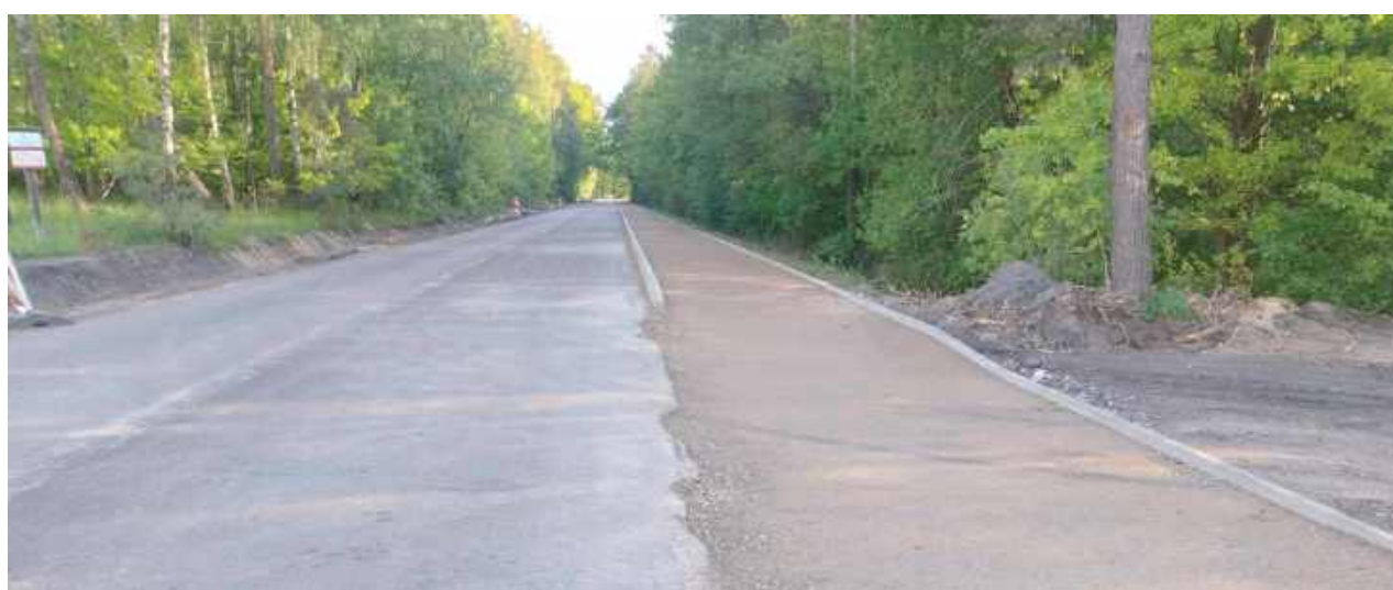
Do wykonania pozostała m.in. warstwa ścieralna nawierzchni, zjazdy z kruszywa, oznakowanie pionowe poziome i prace porządkowe
