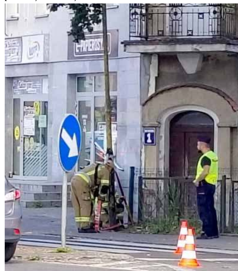
Asysta policjantów w trakcie zabezpieczania konstrukcji
