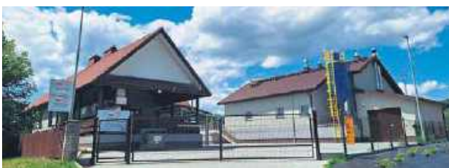
Oczyszczalnia w Tęgorz
