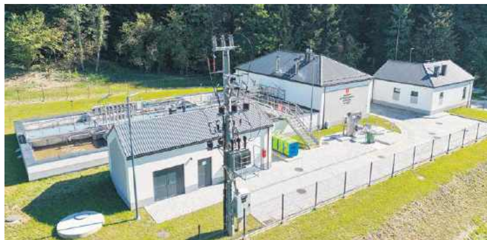
Oczyszczalnia ścieków w Łęce
