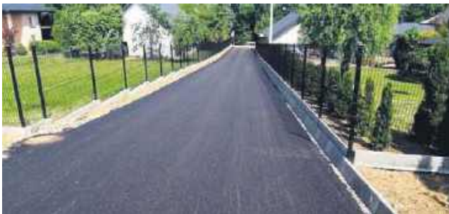
Droga Łososina Dolna-Jarostowa
