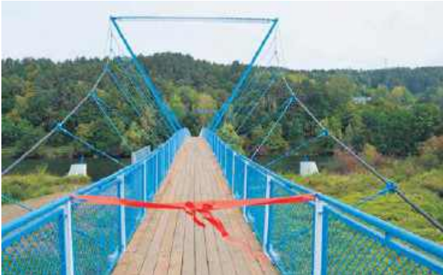
Kładka wisząca pieszo-rowerowa Witowice Dolne- Tropie
