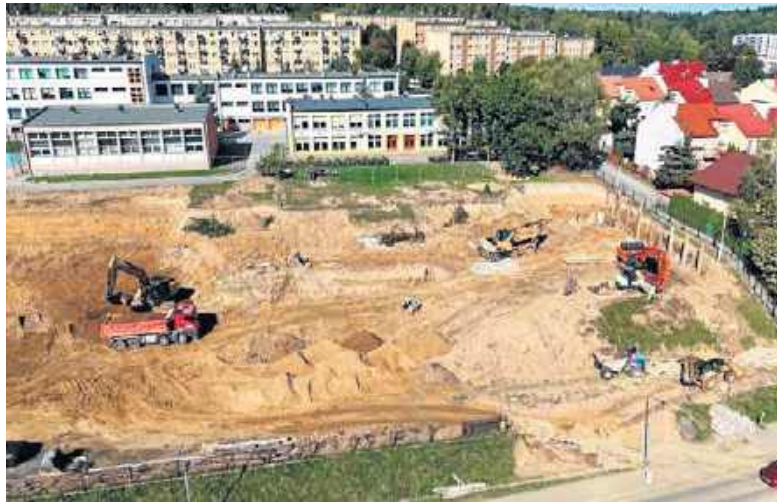
Budowa pierwszego takiego obiektu w Małopolsce trwa
