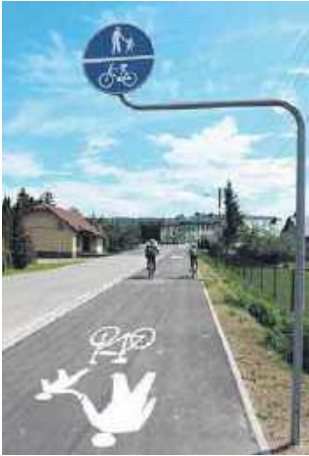
Wybudowano wiele odcinków ścieżek pieszo-rowerowych. Powstają kolejne.
