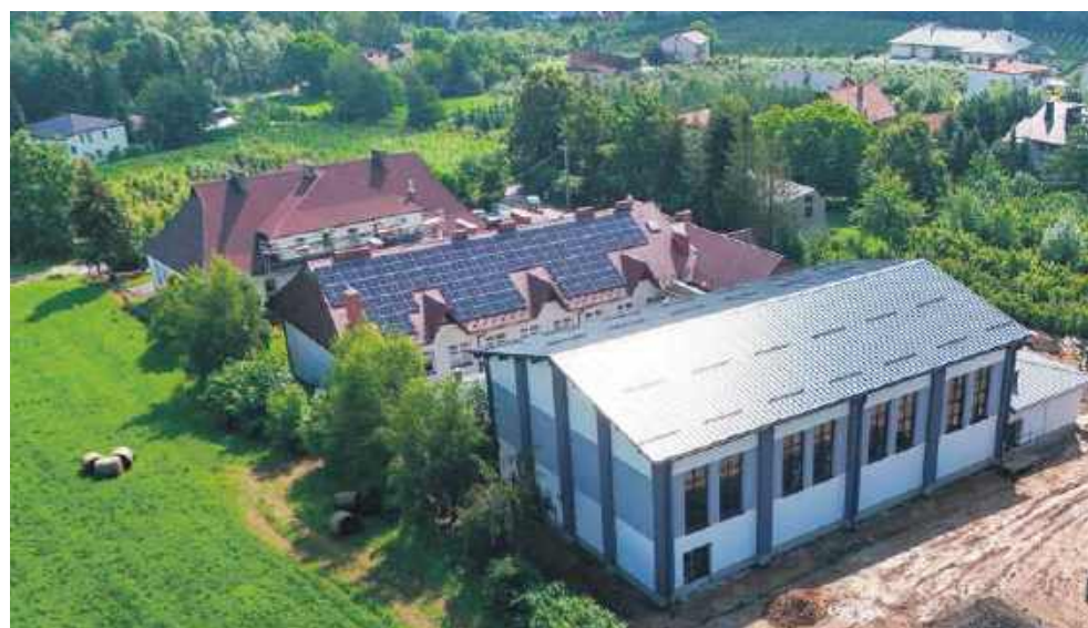
Budowa sali gimnastycznej w Czarnym Potoku
