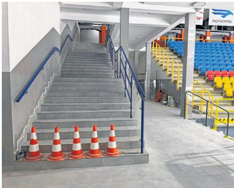
Na Tor-Torze dobiega końca pierwszy etap prowadzonych prac remontowych
