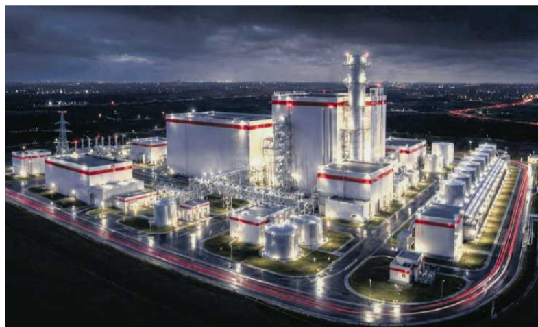
• Elektrownia gazowo - parowa w Gdańsku
