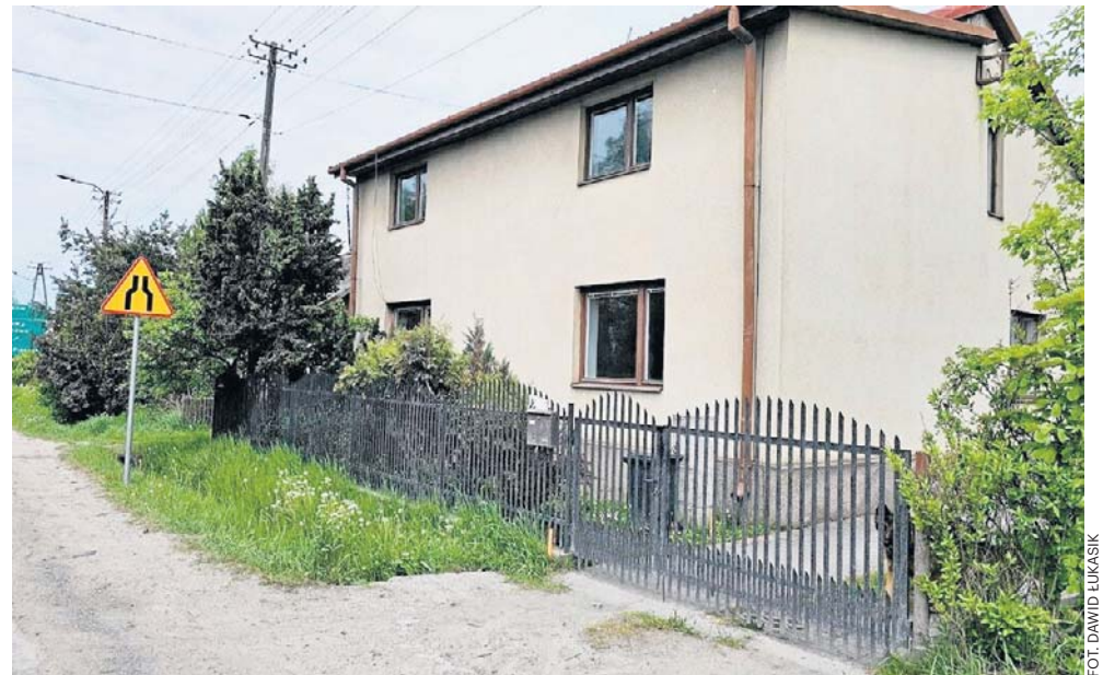
Opuszczone domy w rejonie budowanej trasy S74 przez Kielce — budynki przygotowane do przejścia i wyburzeń w ramach inwestycji
