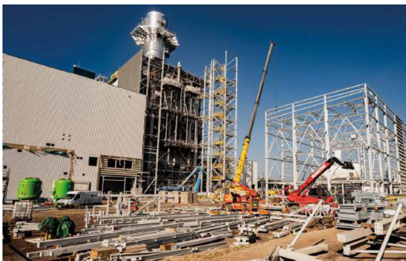
Budowany blok parowo-gazowy PGE Nowy Rybnik
