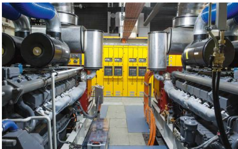
Zestaw generatorów Diesla w Swiss Fort Knox. Gwarantują ciągłość zasilania krytycznych systemów niezależnie od awarii zewnętrznej sieci.
