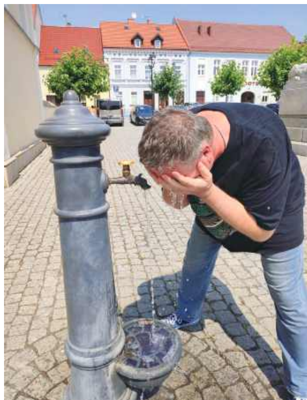
Stylowa kolumna z kranem to praktyczna i estetyczna instalacja na wiązowskim rynku
