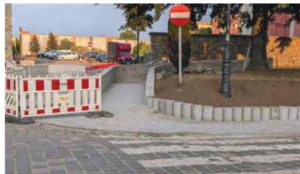
Na plantach miejskich przy ul. Pocztowej trwają końcowe prace związane z rewitalizacją terenu
