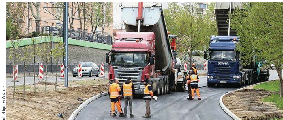
Olsztyn otrzyma 2,3 mln zł na „przebudowę konstrukcji nawierzchni jezdni ulicy Krasickiego”
