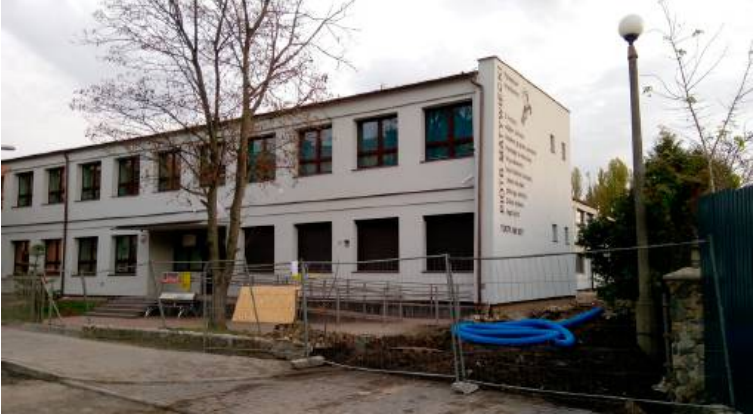
Na zewnątrz do wykonania zostało jeszcze prawie 40% zaplanowanych prac
