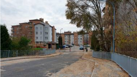
Łącznik ul. Milenijnej z ul. Szeligowskiego odkorkuje wyjazd z osiedla
