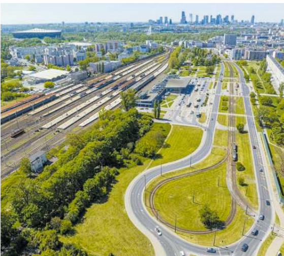
• Dworzec Wschodni od strony ul. Kijowskiej. Tunel pod torami i peronami połączy ją z ul. Lubelską na Kamionku
