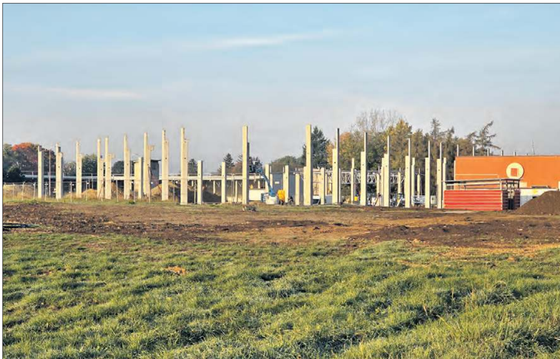
Konstrukcja jednego z budynków nowego centrum handlowego
