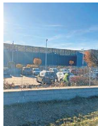
Rozbudowa Centrum Informatyki Resortu Finansów.
