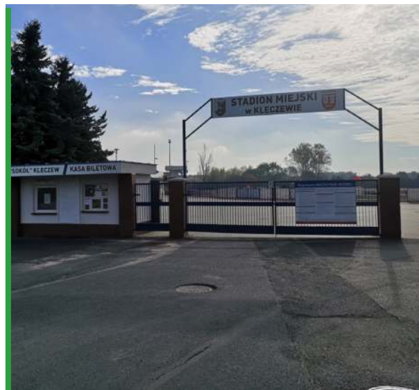
Wejście na kameralny obiekt w Kleczewie.
