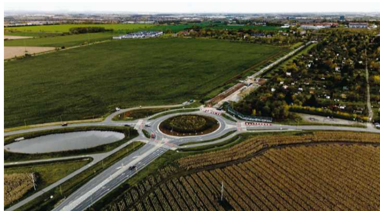
• Dokończona zostanie budowa ostatniego odcinka Wschodniej Obwodnicy Wrocławia. FOT. MATERIAŁY PRASOWE
