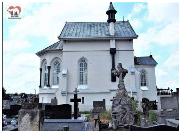
Remont kaplicy cmentarnej rozpoczął się w 2019 roku
