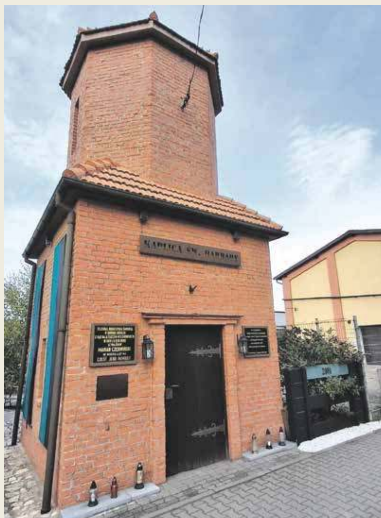
W dawnej transformatorowni emerycy urządzili kaplicę Świętej Barbary
