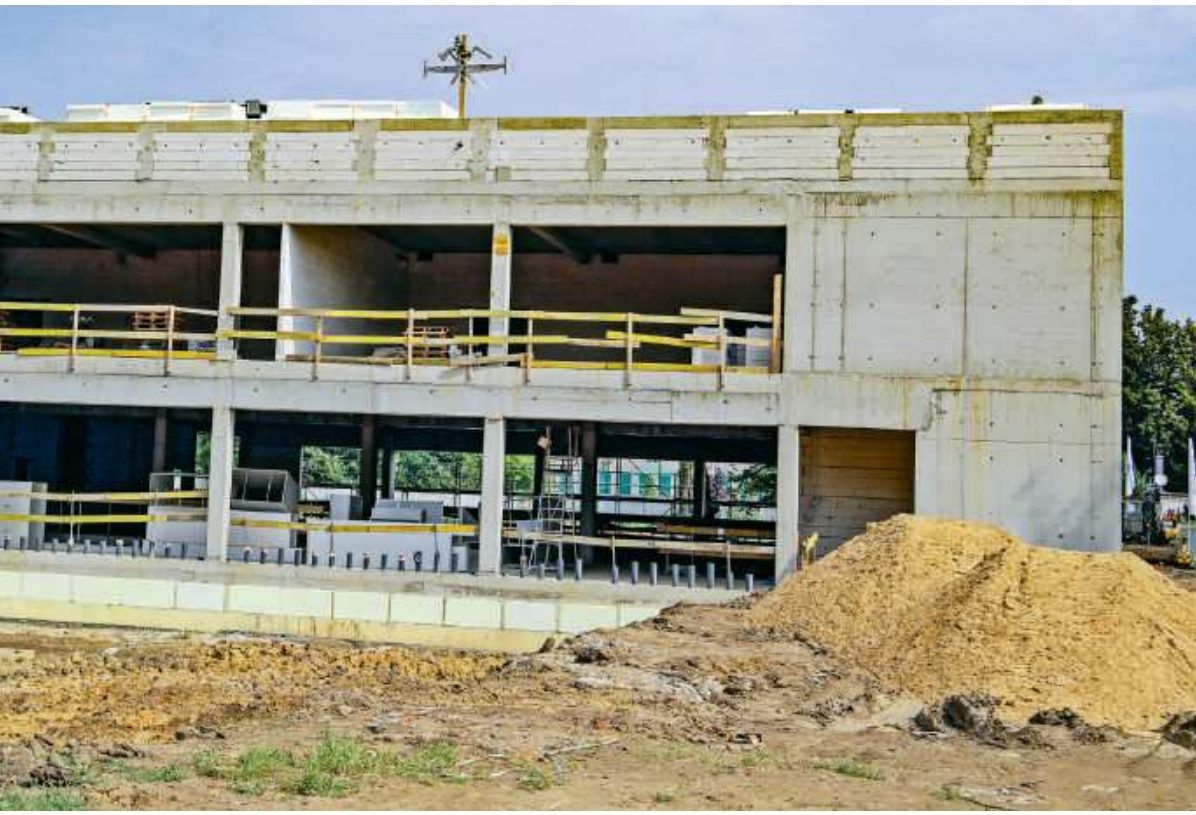
Na budowie kolejnego aquaparku we Wrocławiu | fot. UMW/d
