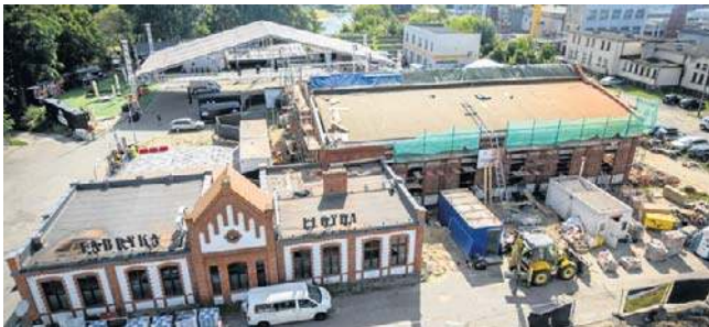
Trwa odbudowa spalonej Fabryki Lloyd
