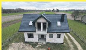
Dom w stanie surowym otwartym, Wólka Siemieńska, 885 851 160
