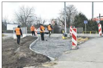
Początkowy odcinek nowej części ścieżki od strony Prudnika
