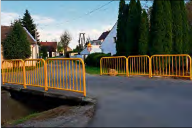
22 kwietnia na mostku obok kaplicy w Pietnej zostały wymienione barierki.
