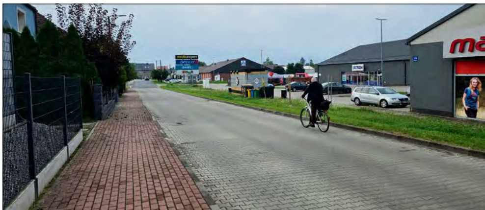
Jednym z dwóch nowych przystanków autobusowych w gminie Krapkowice będzie przystanek przy ul. Ligonia, który ma ułatwić mieszkańcom dostęp do centrum handlowego.
