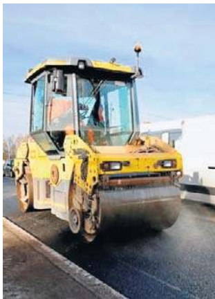
Prace na ul. Brzezińskiej zmierzają do końca
