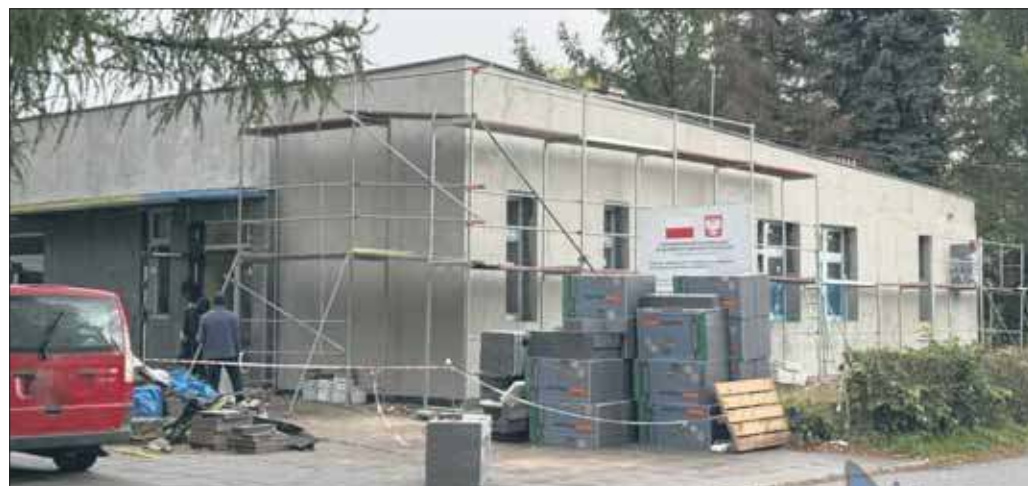
Remont przychodni ZLO Łubowiec
