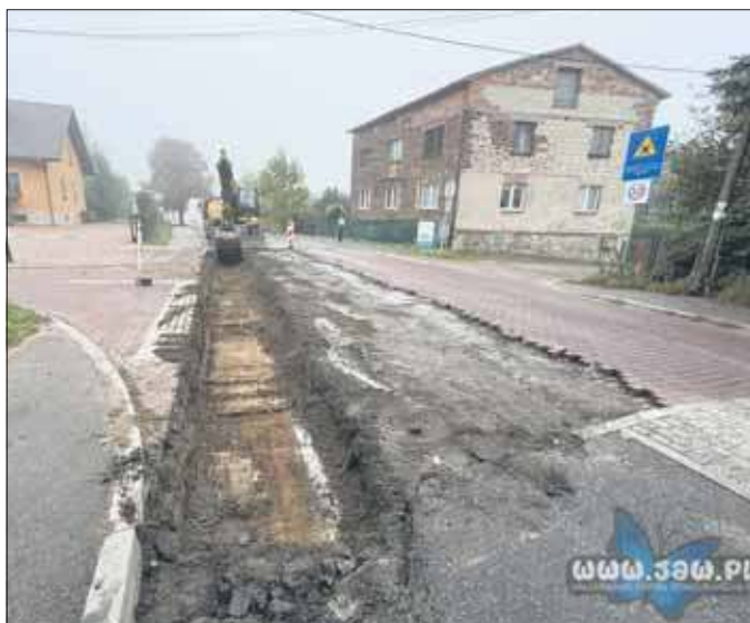
Remont ulicy Jaworznickiej
