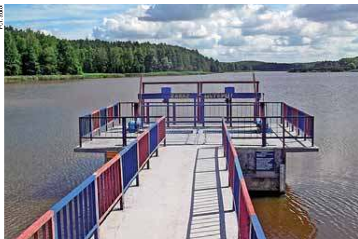
Rzut oka na zalew w Rudzie z nie w pełni szczelnej tamy
