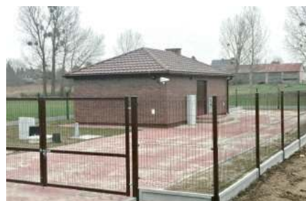
Budynek przepompowni w miejscowości Wielkolas
