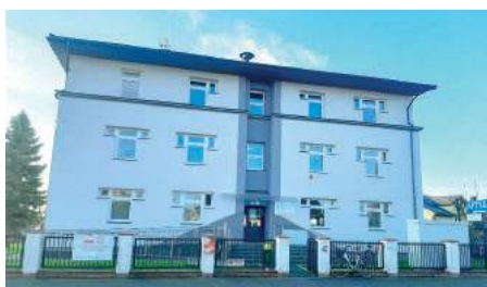
Budynek Urzędu Gminy w Abramowie po termomodernizacji i rozbudowie
