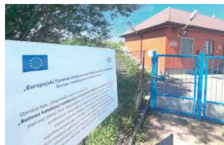
Oczyszczalnia ścieków w Wielkiem po modernizacji
