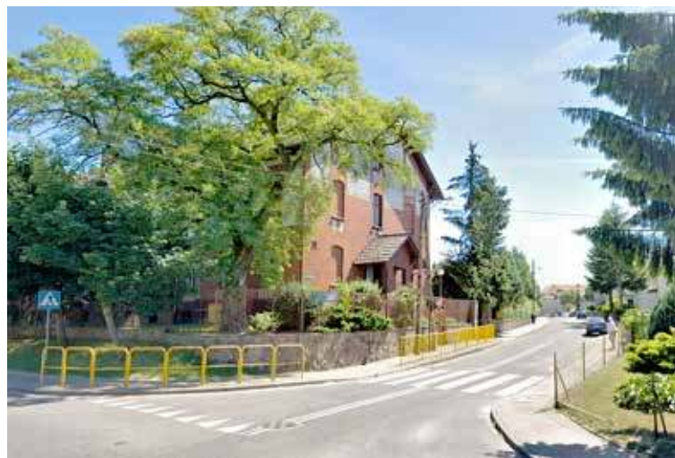
Termomodernizacją zostanie objęty także budynek filii DPS przy ul. Piłsudskiego
