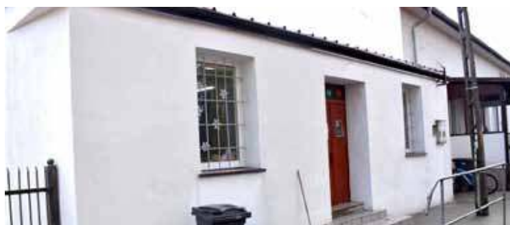
W miejscowości Błotno ocieplono ściany świetlicy i wykonano nową elewację budynku
