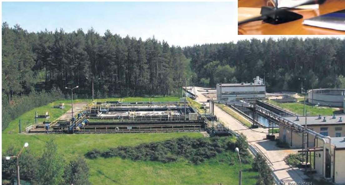
Modernizacja oczyszczalni to jedno z najbardziej oczekiwanych przedsięwzięć przez mieszkańców Tucholi. Ci regularnie skarżą się na smród z kierunku obiektu w Rudzkim Moście. Fot. PK Tuchola
