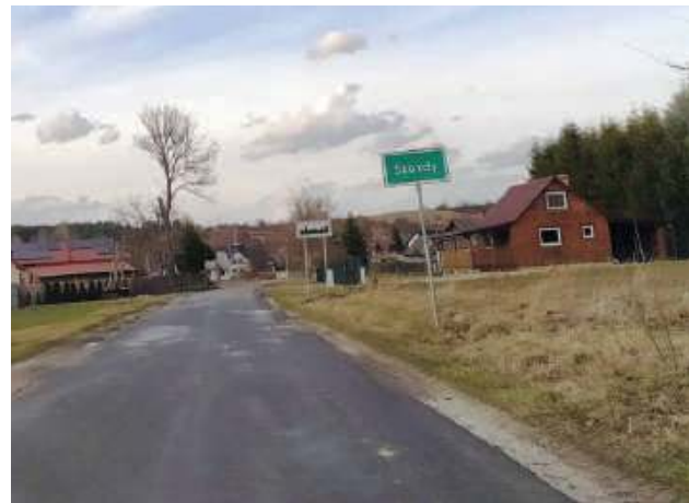
Remont zostanie przeprowadzony na odcinku drogi od Tereszpola-Kukielek przez Szozdy do Soch.
